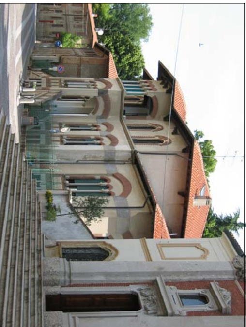
Fig. 274 Asilo Litta, visto da via S. Stefano verso Villa Litta Modigliani
