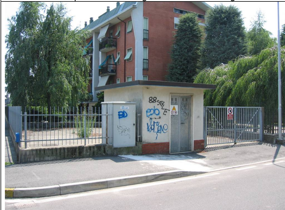
IT03 Impianto Tecnologico Via Dante Alighieri
