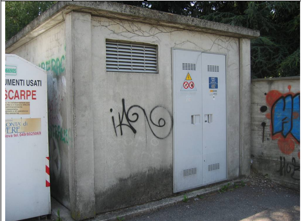
IT08 Impianto Tecnologico Via della Misericordia
