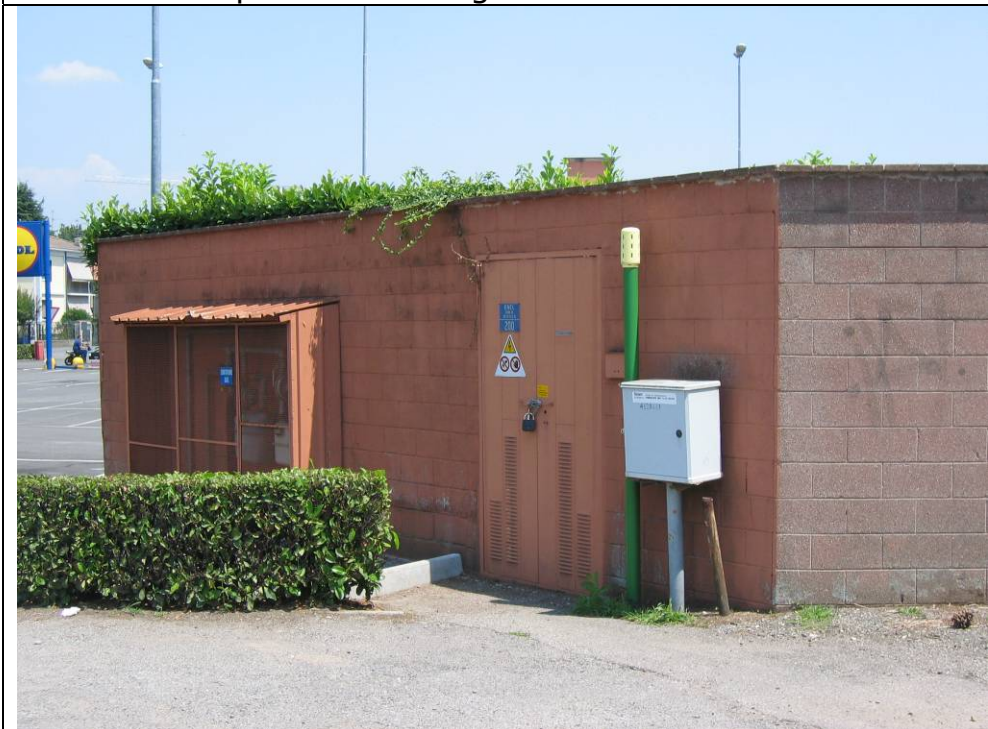
IT07 Impianto Tecnologico Via della Misericordia
