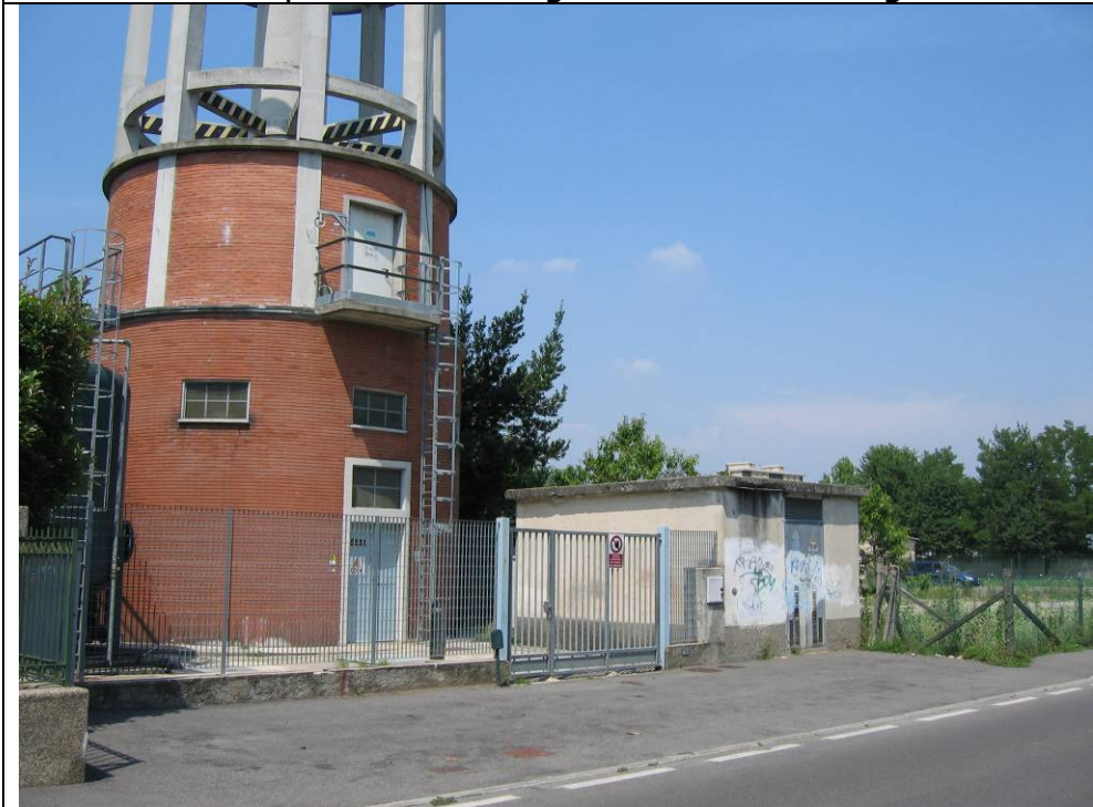
IT02 Impianto Tecnologico Via Dante Alighieri
