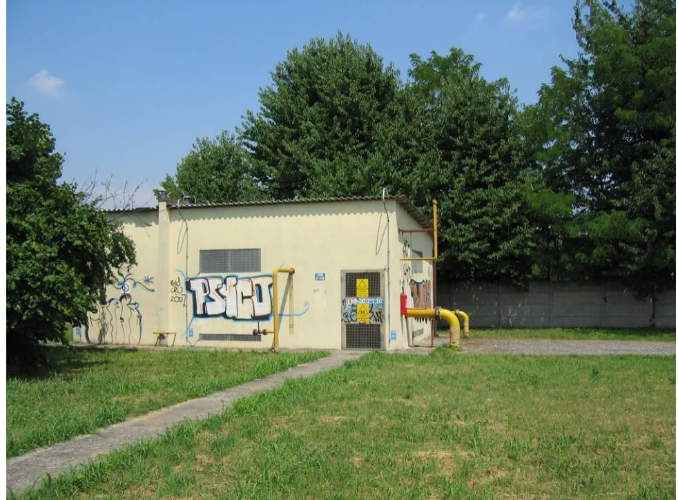
IT01 Impianto Tecnologico Via Europa / via Monte Grappa
