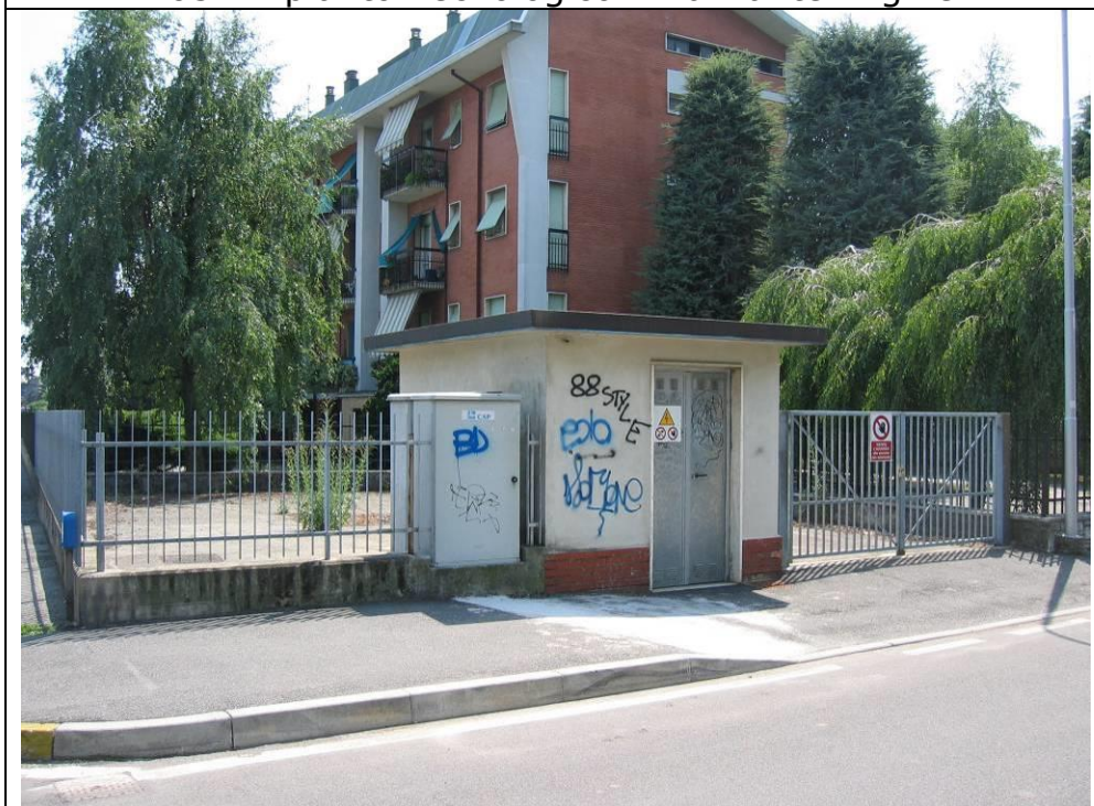
IT03 Impianto Tecnologico Via Dante Alighieri
