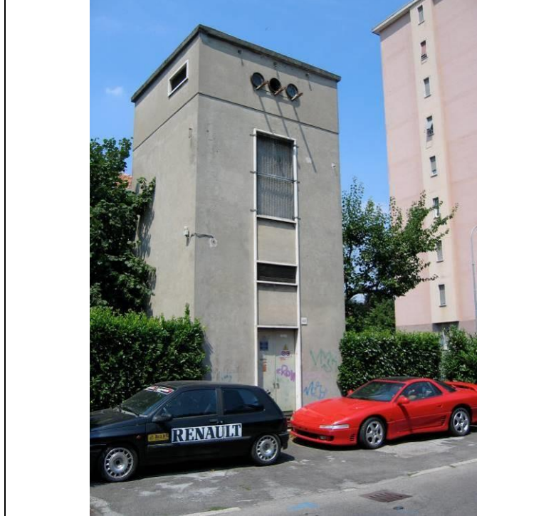
IT04 Impianto Tecnologico Via Rimembranze
