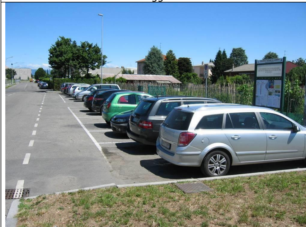
P53 Parcheggio Via Fermi
