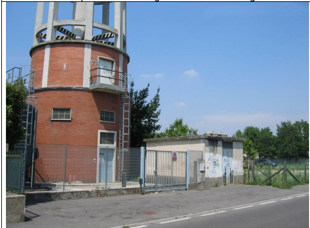
IT02 Impianto Tecnologico Via Dante Alighieri
